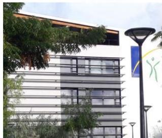
Compact béton récent avec brises soleil peu efficaces en façade ouest (espacement entre lames trop grand et inclinaison nulle)
