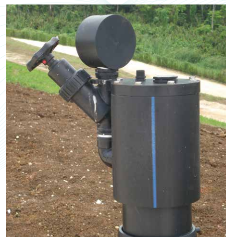
Puits de méthane - Gabarre
