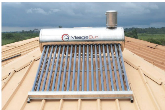
Illustration 4.18: Tubes sous vide et chauffe-eau solaire installé sur toit
