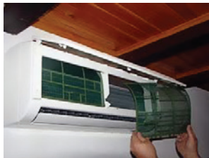
Illustration 3.16: Changement des filtres sur climatiseur individuel split
