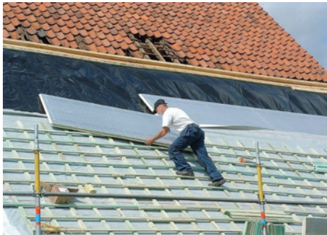
Illustration 2.8: Travaux d'isolation d'un toit par l'extérieur
