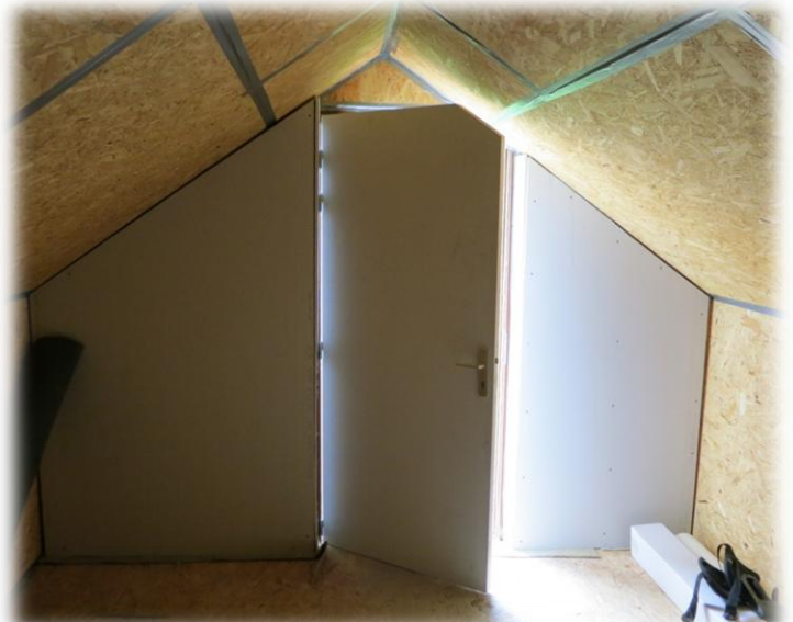
Photos ci-dessus : doublage des pignons dans le local d'émission.
