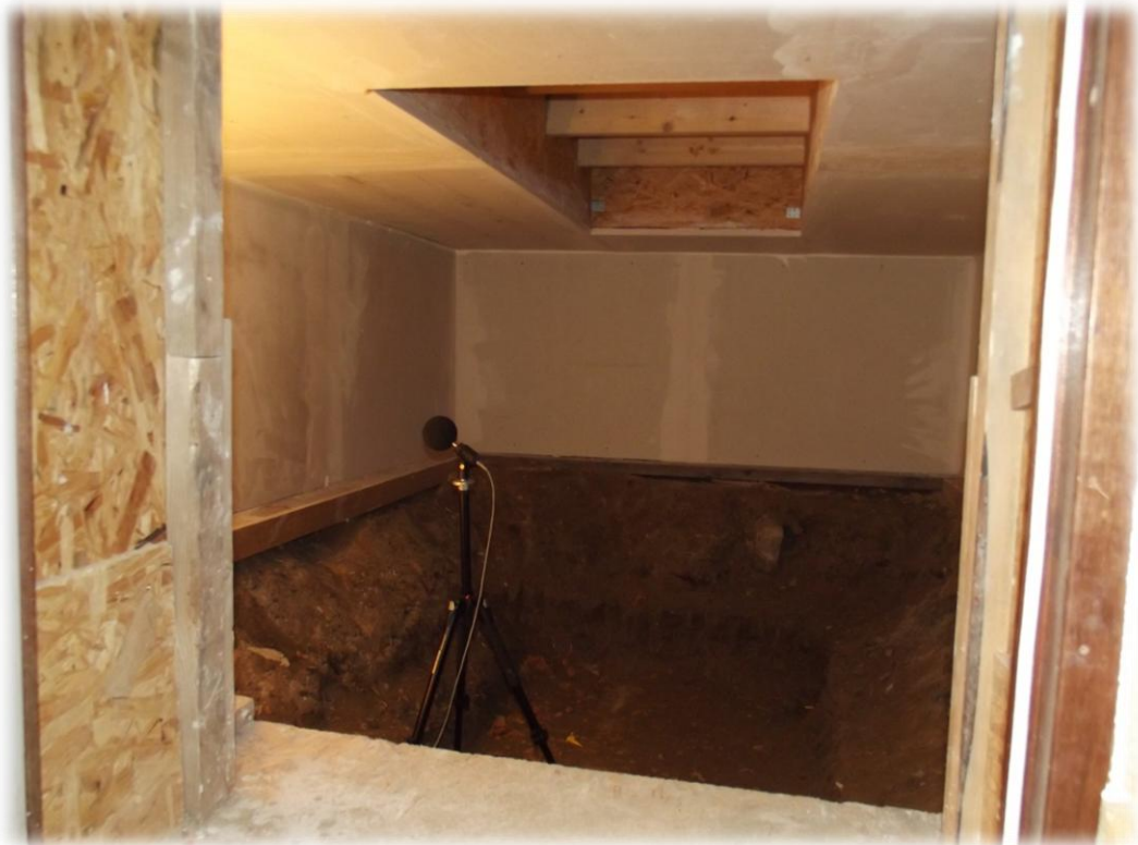
Photo ci-dessus : décaissement du local de réception et doublage des murs.
