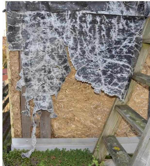
Pare-pluie dégradé par manque de protection (bardage)
