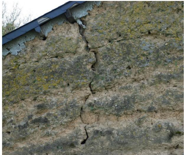
Fissure de poinçonnement due au manque de pièce de répartition des charges et au manque d'entretien de la couverture.
