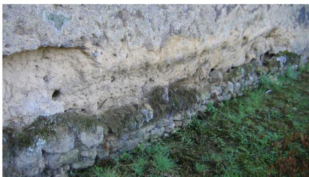
Dégradation de la bauge à la limite du soubassement et perforation des parois par des insectes et petits rongeurs.
