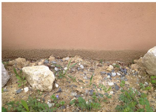
Erosion de l'enduit : absence de protection en pied de mur (Source: AQC)
