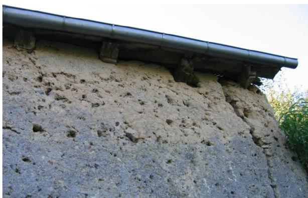
Dégradation du matériau sous débord de toiture et désolidarisation des murs.
