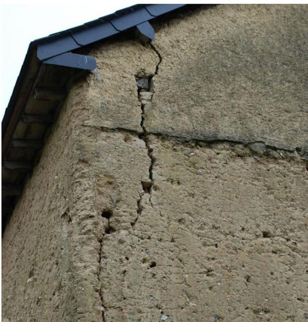
Fissure d'angle, désolidarisation des murs dues à une modification ou à un mauvais entretien de la charpente.
