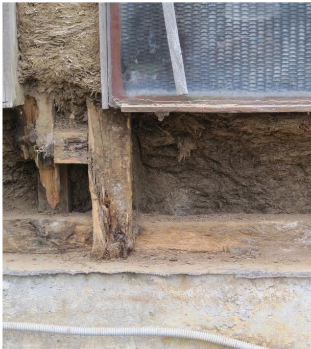
Pourriture du remplissage et de l'ossature bois suite à la mise en œuvre d'un enduit sans garde au sol sur une façade exposée.
