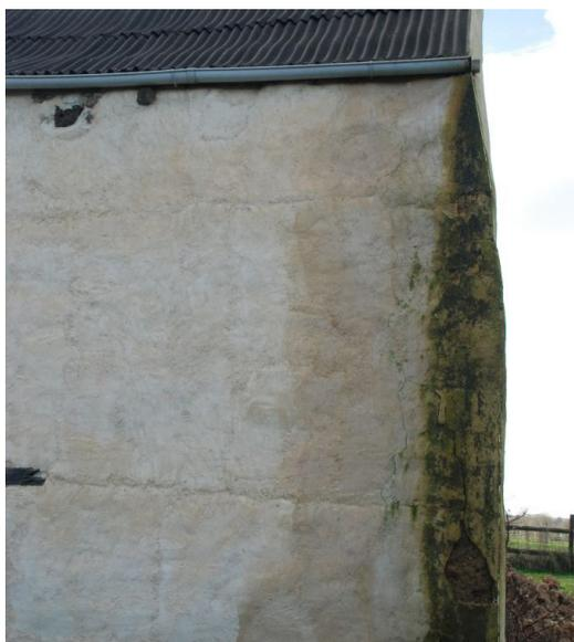
Humidité dans l'angle de la construction due à l'absence de descente d'eau
