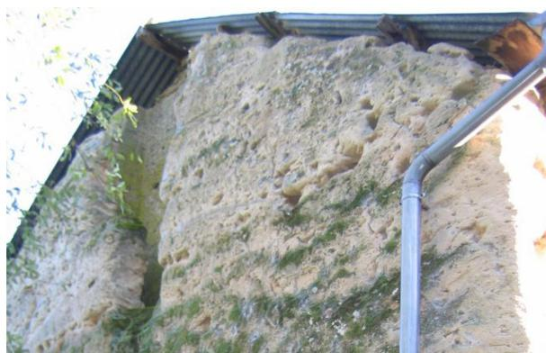
Fonte de la bauge d'un mur non protégé : pas de débord de toiture et absence de zinguerie
