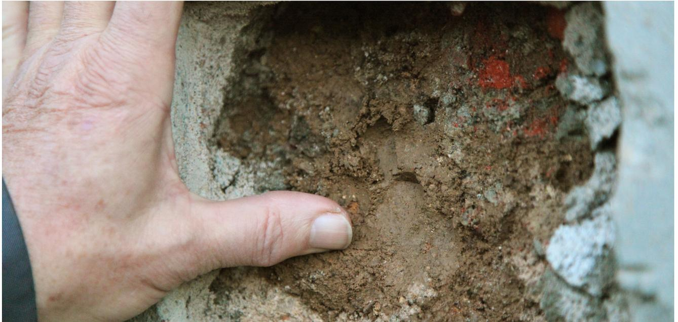
*Pisé humidifié sous plusieurs couches d'enduit ciment qui garde la trace du doigt.
