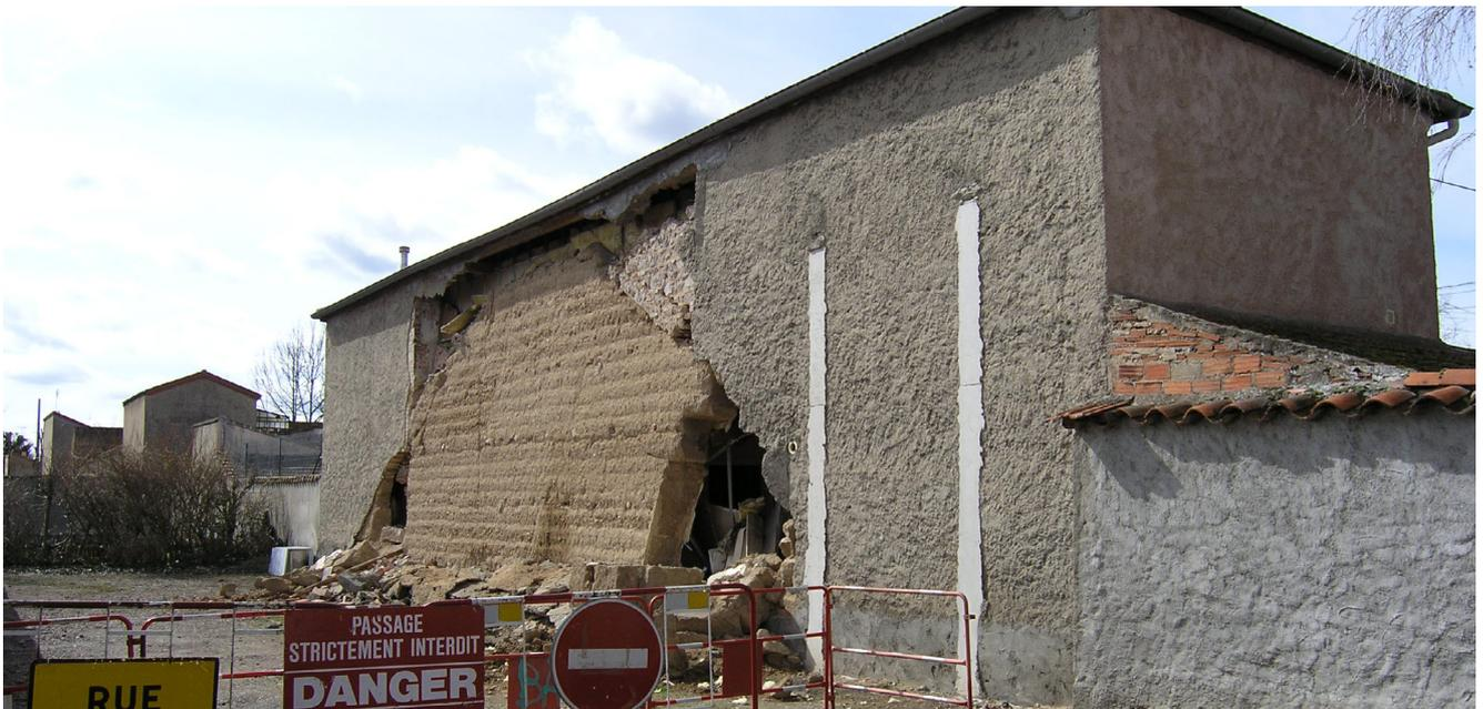
*Effondrement partiel d'un mur en pisé recouvert d'enduit ciment.
