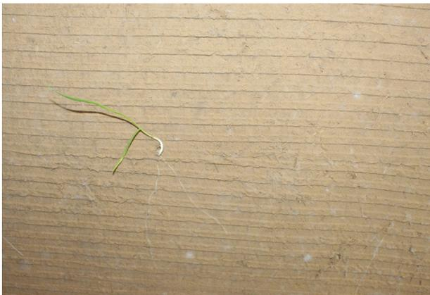
Germination d'une graine présente dans l'enduit. (Source: AQC)
