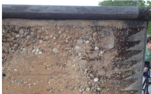
Dégradation du parement d'un muret en pisé stabilisé
