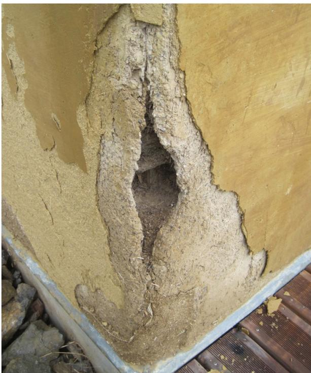
Dégradation de l'enduit à la chaux sur un remplissage en terre paille, enduit trop épais, mal dosé sur un angle exposé aux intempéries (Crédit photo : Lucie Dautreppe et Charles Cintré)
