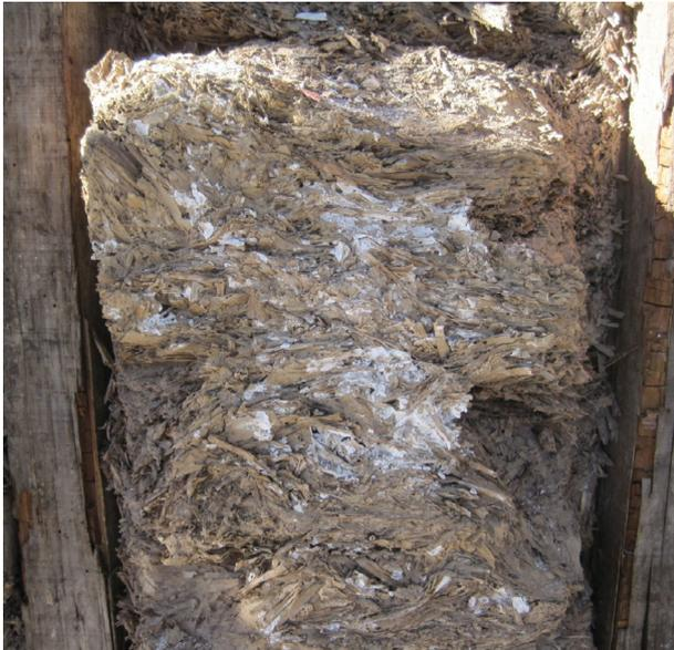
Remplissage endommagé par l'infiltration d'eau dans des enduits fissurés.
