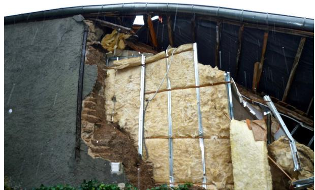
*Effondrement d'une maison en pisé rénovée sans prendre en compte la compatibilité des isolants vis à vis des transferts de vapeur d'eau dans la paroi.*
