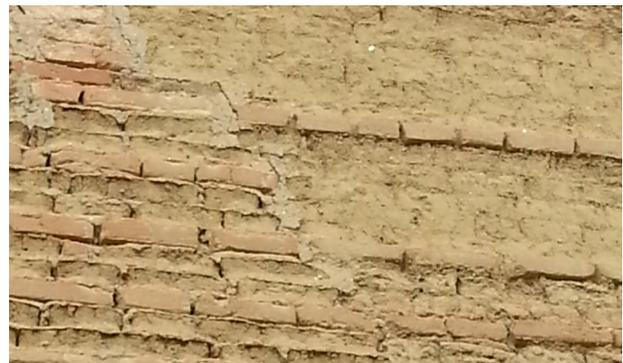
Bâtiment industriel du XIX<sup>ème</sup> siècle (Tarn), construit en adobes et briques foraines hourdées à la terre. Une ouverture a été reprise avec un mortier de chaux/ciment. On observe la différence de fonte (due au rejaillissement des eaux de pluie sur la corniche) des adobes hourdées avec un mortier de chaux/ciment, dont le joint reste saillant, par rapport à celles hourdées à la terre.
