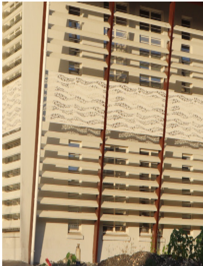
Brise soleil en façade d'un bâtiment.
