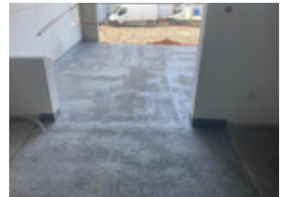
Étanchéité du sol du bâtiment
