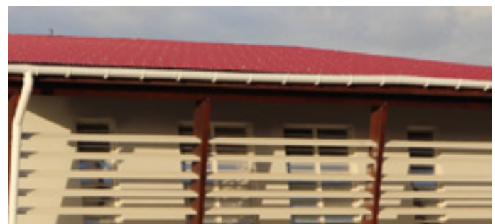
Pare - Soleil installé sur un bâtiment
