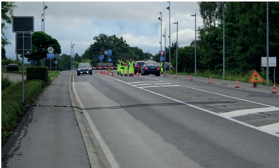
Utilisation de feux de chantier pour la réalisation d'une enquête OD ; la pose de compteurs temporaires peut contribuer au redressement.
