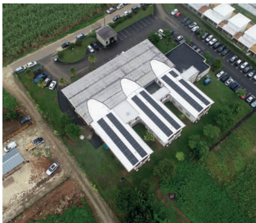
Installation Photovoltaïque, Centre des impôts, Lamentin. Crédit photo : Dac Antilles.
