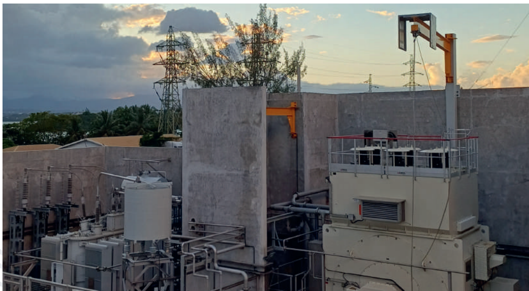
Installation du compensateur synchrone, Jarry, Baie-Mahault. Crédit photo : EDF SEI
