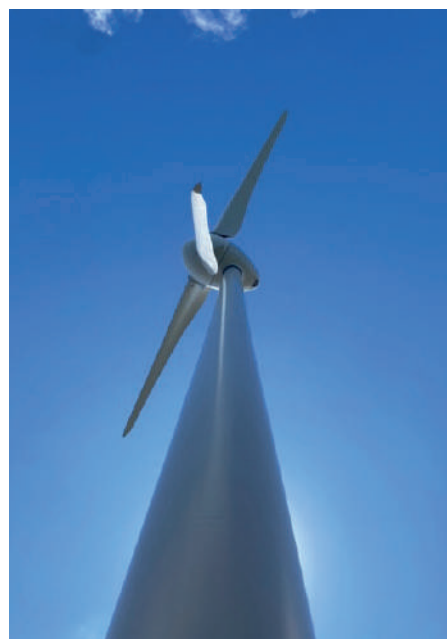
Éolienne en fonctionnement, Capesterre de Marie-Galante. Crédit photo : Synergiles.
