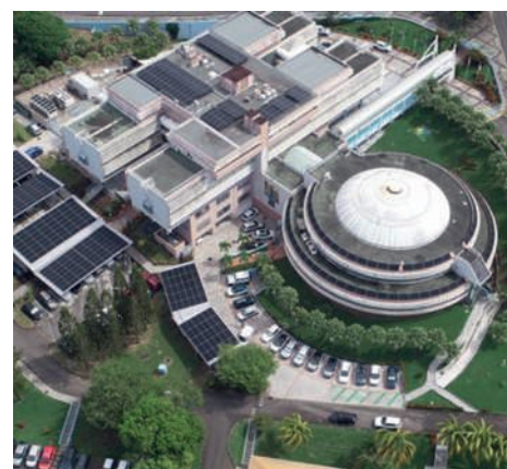
Installation PhotoVoltaïque, Hôtel de Région, Basse-Terre. Crédit photo : Dac Antilles
